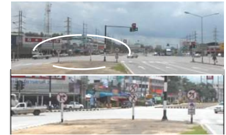
รูปที่ 3.4.3 ป้ายจราจรที่ติดตั้งอยู่บริเวณสี่แยกสถานอาหาร อำเภออินทร์บุรีซึ่งเป็นสี่แยกสัญญาณไฟจราจรขนาดใหญ่ อาจสร้างความสับสนแก่ผู้ขับขี่เนื่องจากมีจำนวนมากและสับสน
