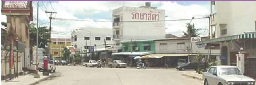
รูปที่ 3.3.3 สามแยกอันตรายในจังหวัดขอนแก่น ซึ่งทางแยกไม่มีป้ายและเครื่องหมายจราจรควบคุมทางแยก ไม่มีการแนะนำผู้ขับขี่ถึงบริเวณที่ควรหยุดรอ ช่องทางที่ควรวิ่งตรงผ่านทางแยก ช่องทางที่ควรจะเลี้ยว หรือ แม้แต่สีที่ใช้ในการเข้าใช้ทางแยก วารสารวิศวกรรมโยธา (หน้า: ยอดผล ธนาบุญรัตน์, 2006)
