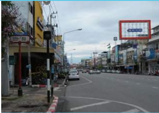
รูปที่ 1.3.2 ทางเชื่อมใกล้ทางแยก เป็นลักษณะที่พบเห็นทั่วไปบริเวณทางแยกในประเทศไทย ที่ซึ่งทางแยกขาดการควบคุมการเชื่อมต่อจากพื้นที่ข้างทาง ในรูปนี้แสดงทางเชื่อมใกล้ทางแยก บริเวณสามแยกอันตรายใน อ.หัวหินซึ่งรถที่ออกมาจากทางเชื่อมจะตัดกระแสจราจรของทางสายหลัก และมักมีพฤติกรรมขับขี้อ่อนคร ซึ่งเป็นการเพิ่มจุดขัดแย้งบริเวณทางแยกอันตรายให้มากยิ่งขึ้น
