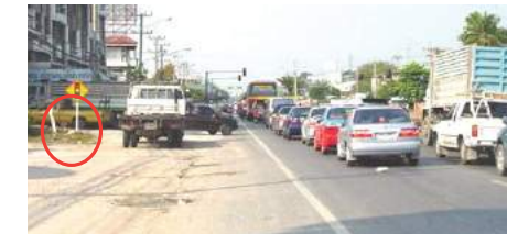
รูปที่ 3.2.2 ป้ายเตือนทางแยกสัญญาณไฟ ซึ่งติดตั้งอยู่ในตำแหน่งที่ไม่สามารถสังเกตเห็นได้อย่างชัดเจน ใกล้จากขอบทาง และมีสภาพแวดล้อมที่พร้อมจะบังป้ายได้ตลอดเวลา ลักษณะการติดตั้งป้ายเตือนเช่นนี้ไม่สามารถเตือนผู้ขับขี่ถึงทางแยกสัญญาณไฟข้างหน้าได้ (ที่มา: ยอดพล ธนบุญธรัตน์, 2006)
