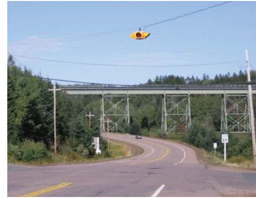
รูปที่ 1.2.3 การแขวนสัญญาณไฟกระพริบเตือนอันตรายไว้บนทางแยก เพื่อให้ผู้ขับขีทุกทิศสามารถมองเห็นสัญญาณไฟที่แขวนเหนือหัวจะช่วยเหลือประสิทธิภาพของป้ายและเครื่องหมายจราจรตามมาตรฐาน มาตรการนี้มีการใช้โดยทั่วไปในประเทศแคนาดา แต่น่าเสียดายที่ไม่มีกรณีประเมินผลไว้อย่างเป็นทางการ (ที่มา: TAC, 2006)
