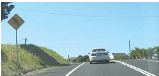
รูปที่ 1.2.2 การเตือนทางแยกที่ซ่อนอยู่หลังโค้ง ตัวอย่างป้ายเตือนซึ่งติดตั้งบนทางสายหลัก ในประเทศออสเตรเลีย เตือนผู้ขับขึ้นถึงทางเชื่อมในโค้งข้างหน้า ซึ่งผู้ขับจะมองไม่เห็น เนื่องจากถูกยอดโค้งตั้งบังไว้
