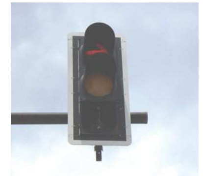
รูปที่ 2.3.1 สภาพสัญญาณไฟจราจรที่โคมสัญญาณไฟเขียวหลุดหายไป ก่อนความสนใจของผู้ขับขี่ ซึ่งสถานการณ์ดังกล่าวจะอันตรายมากขึ้นหากโคมไฟที่หลุดหายเป็นโคมสัญญาณไฟแดง
