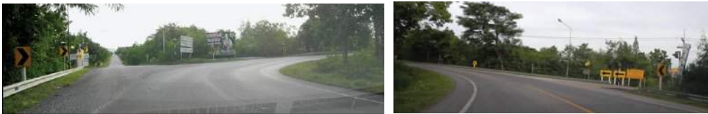
รูปที่ 1.1.2 ทางเชื่อมที่อยู่กลางโค้งราบ (รูปซ้าย) หากต้องการขับรถจากตัวจังหวัดนครราชสีมา เพื่อเดินทางไปยังอ.สวนผึ้ง เมื่อถึงถนนบริเวณนี้ผู้ขับขี่ต้องขับไปตามแนวถนนสายหลัก(ตามแนวโค้งทางขวา) แต่การมีทางเชื่อมบริเวณกลางโค้งดังกล่าว ทำให้บริเวณนี้มีลักษณะเป็นทางแยกซึ่งอาจสร้างความสับสนแก่ผู้ไม่ชำนาญเส้นทางว่าควรจะไปตามเส้นทางใด ควรจะขับตรงไป(เข้าสู่ทางเชื่อม) หรือไปตามทางโค้งขวา นอกจากนี้การเชื่อมทางเป็นมุมแหลมที่โค้งนอก ทำให้ระยะมองเห็นในบริเวณนี้มีอย่างจำกัดโดยเฉพาะสำหรับผู้ขับขี่ที่ออกจากทางเชื่อม (รูปขวา)
