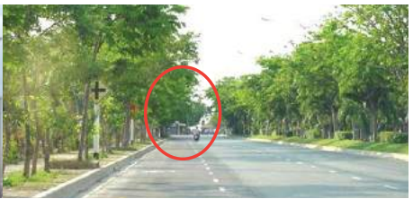
รูปที่ 3.2.3 ป้ายเตือนทางแยกสัญญาณไฟถูกบดบังโดยต้นไม้ข้างทาง โดยเฉพาะในช่วงหน้าฝน (ที่มา: ยอดพล ธนบุญธรัตน์, 2006)
