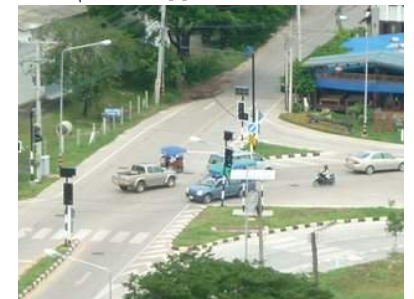
รูปที่ 2.3.2 ทางแยกหลายขาในจังหวัดขอนแก่น ผู้ขับขี่สับสนกับสัญญาณไฟที่สามารถมองเห็นได้จากหลายทิศทางแยกที่จะเข้าใจว่าสัญญาณไฟใดจึงเป็นรถในทิศทางใด สัญญาณไฟ 1 โคม สามารถมองเห็นได้จากทั้ง 2 ขาของทางแยก เนื่องจากขาของทางแยกติดกันเป็นแนบเหลี่ยม (ที่มา: อนุวัฒน์ ปิตานนท์, 2012)
