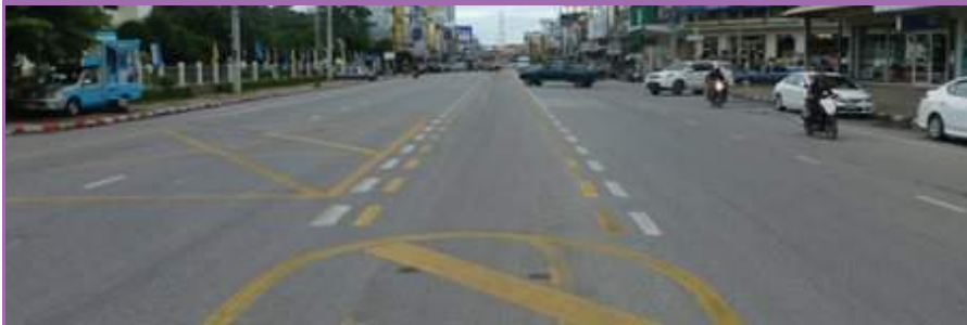
รูปที่ 3.3.4 เครื่องหมายจราจรบนพื้นทางบริเวณทางแยกใน อำเภอหัวหิน สร้างความสับสนให้แก่ผู้ขับขี่ทางแยก
