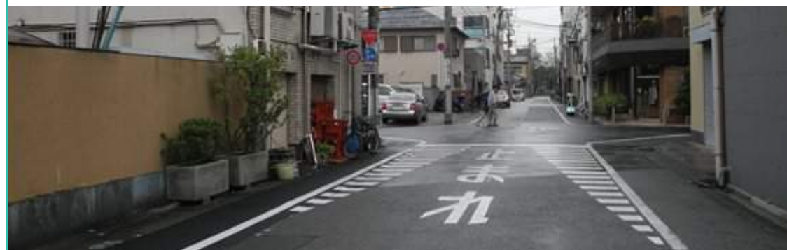
รูปที่ 4.2.2 การทำเครื่องหมายจราจรบนพื้นทางเพื่อเตือนทางแยกและลดความเร็วเข้าสู่ทางแยกในชุมชนในประเทศญี่ปุ่น
