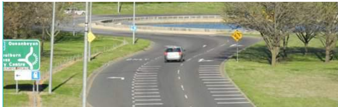
รูปที่ 4.2.1 การทำเครื่องหมายจราจรบนพื้นทางเพื่อเตือนวงเวียนและลดความเร็วของรถที่จะเข้าสู่วงเวียนในประเทศออสเตรเลีย
