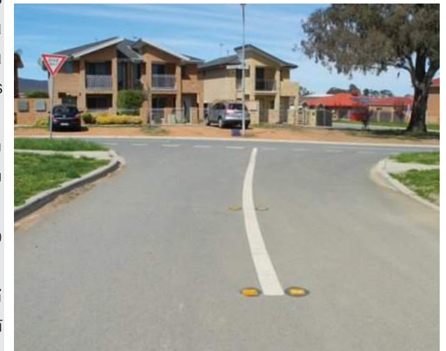
รูปที่ 3.3.2 การควบคุมทางแยกในชุมชนในประเทศออสเตรเลีย ด้วยเส้นใต้ทาง (เส้นสีขาวขวางถนน) ประกอบกับป้ายใต้ทาง และเพิ่มปุ่มจราจรบนผิวทางเพื่อการมองเห็นทางแยกในเวลากลางคืน
