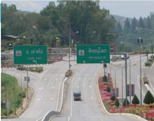
รูปที่ 1.2.1 ทางแยกที่ตั้งอยู่กลางโค้งตั้งสองโค้งบนทางสายหลัก จากรูปทางแยกสัญญาณไฟขนาดใหญ่ ตั้งอยู่ระหว่างโค้งตั้งคว่ำ 2 โค้งเส้นทาง อาจไม่ทันสังเกตว่ามีทางแยกสัญญาณไฟข้างหน้าหรือแม้แต่มองข้ามโดยขาดการสังเกตเส้นทาง อาจมีปัญหาในการหยุดรถ โดยเฉพาะเมื่อฝนตกถนนลื่นหรือรถถลจนมาด้วยความเร็วสูง
