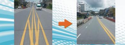
มีการกีดขวางบริเวณคอสะพานทำให้เกิดอุบัติเหตุบ่อยครั้ง วางแนว barrier ป้องกันการกีดขวางบริเวณคอสะพาน
