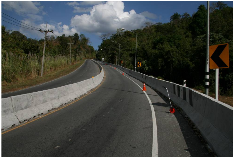
รูปที่ 19 สภาพถนนในช่วงบริเวณที่เกิดเหตุ
