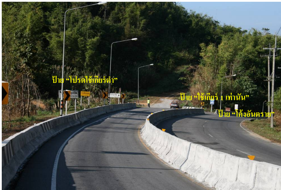
รูปที่ 22 ป้ายเตือนก่อนถึงบริเวณที่เกิดเหตุ
