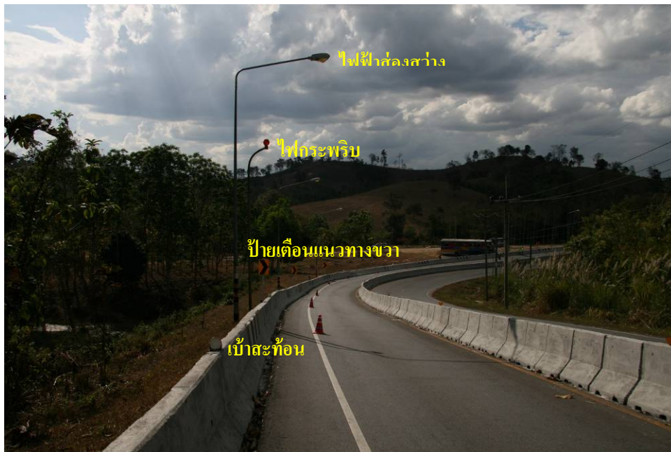
รูปที่ 23 อุปกรณ์ถนนใหม่บริเวณที่เกิดเหตุ
