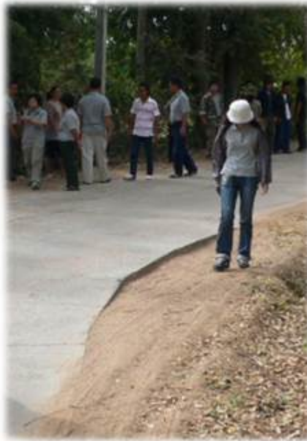
รูปที่ 3.35 ขอบทางโค้งด้านในต่างระดับกับดินข้างทาง
