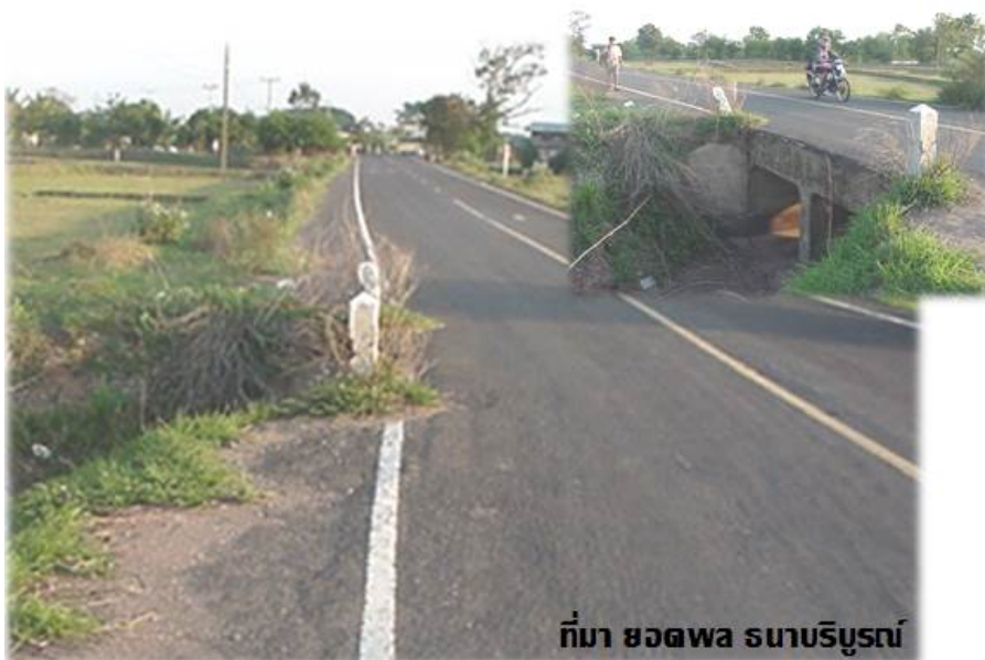
รูปที่ 3.39 หน้าตัดถนนที่ไม่สม่ำเสมอโดยไหล่ทางขาดหายไปในช่วงท่อลอดระบายน้ำ
