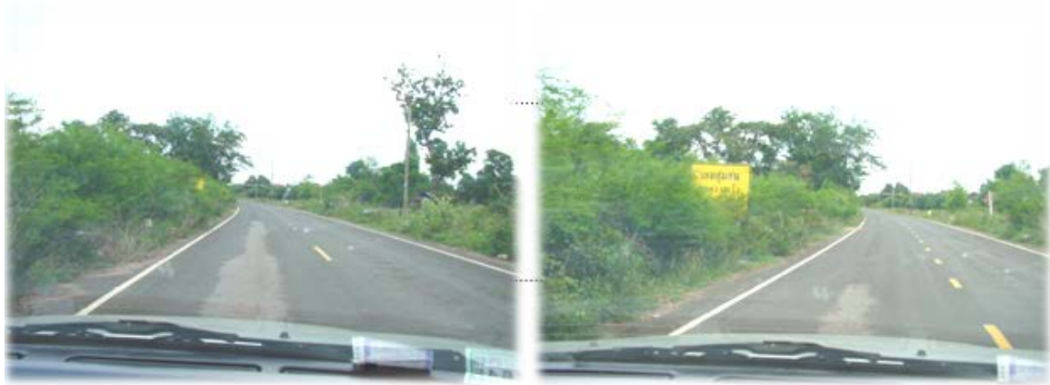
รูปที่ 3.43 ป้ายเตือน เขตชุมชนลดความเร็ว ที่ขาดการบำรุงรักษา
