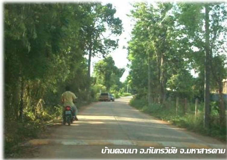
รูปที่ 3.45 เนินชะลอความเร็วในเขตชุมชน
