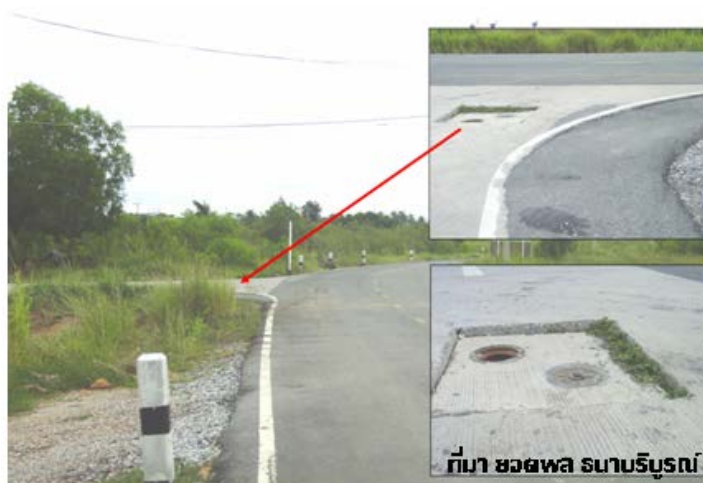
รูปที่ 3.22 ฝาท่อระบายน้ำต่างระดับบริเวณทางแยก
