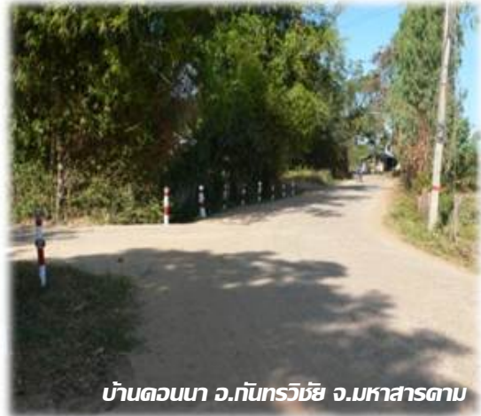
(ก) ก่อนปรับปรุง (ข) หลังปรับปรุง รูปที่ 3.29 ตัดถางพุ่มไม้และติดตั้งหลักนำโค้งบริเวณโค้งที่มีทางเชื่อม
