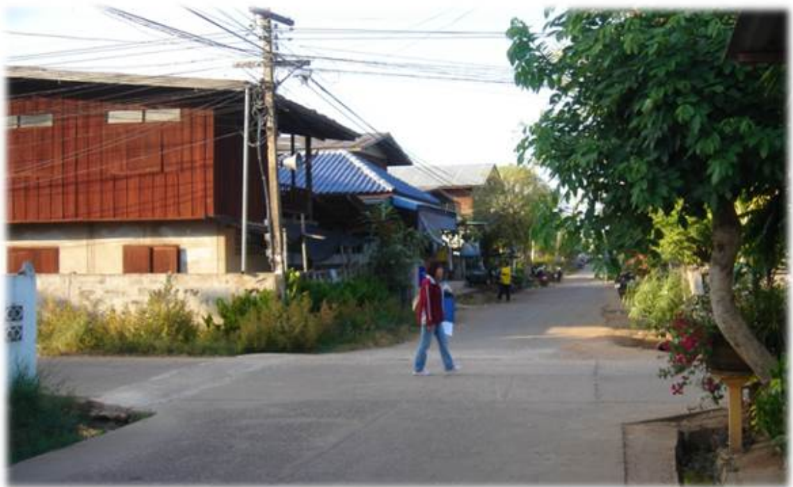
รูปที่ 3.23 รางระบายน้ำคอนกรีตแบบเปิดบริเวณทางแยกในชุมชนอาจเพิ่มความรุนแรงของอุบัติเหตุ
