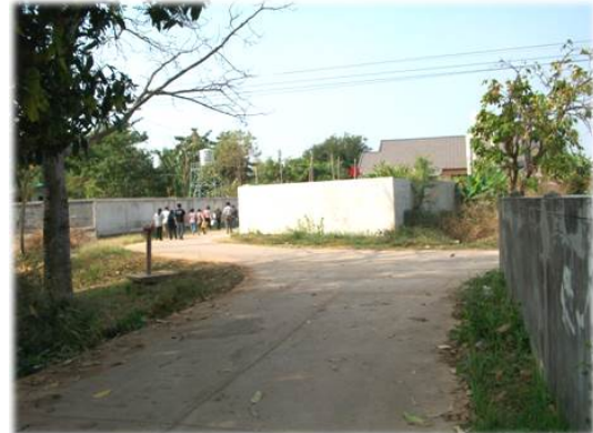
รูปที่ 3.20 ทางแยกที่มีแนวกำแพงและพุ่มไม้บดบังการมองเห็นรถในทิศทางอื่นๆ
