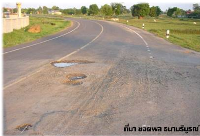
รูปที่ 3.21 ทางแยกที่มีผิวทางลื่นเป็นหลุมบ่อ
