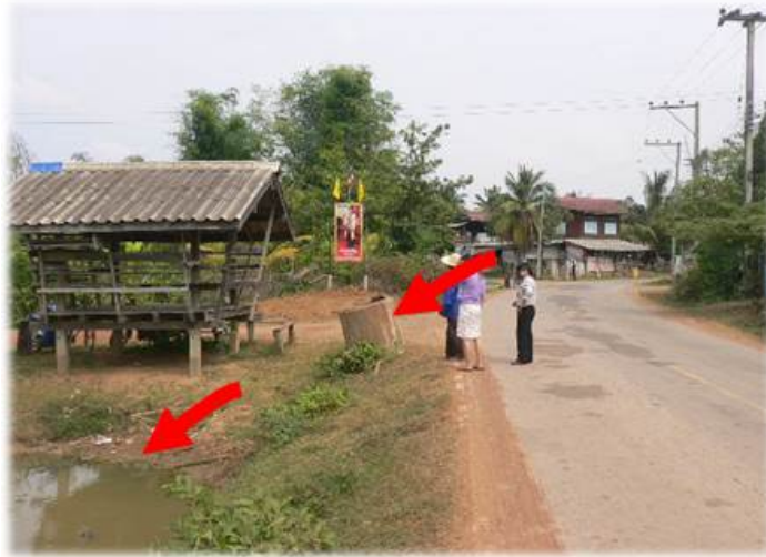
รูปที่ 3.36 ทางโค้งที่มีสภาพอันตรายบริเวณ โค้งนอก(ท่อคอนกรีตและบ่อน้ำ)
