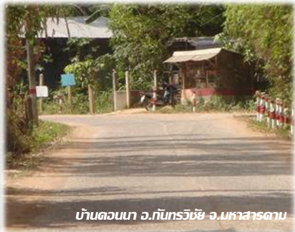
(ก) ก่อนปรับปรุง (ข) หลังปรับปรุง รูปที่ 3.30 หลักนำโค้งที่ไม่สม่ำเสมอเนื่องจากทางเข้าออกบ้านพัก
