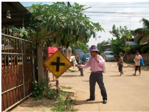
(ค) ติดตั้งป้ายเตือนทางแยก
