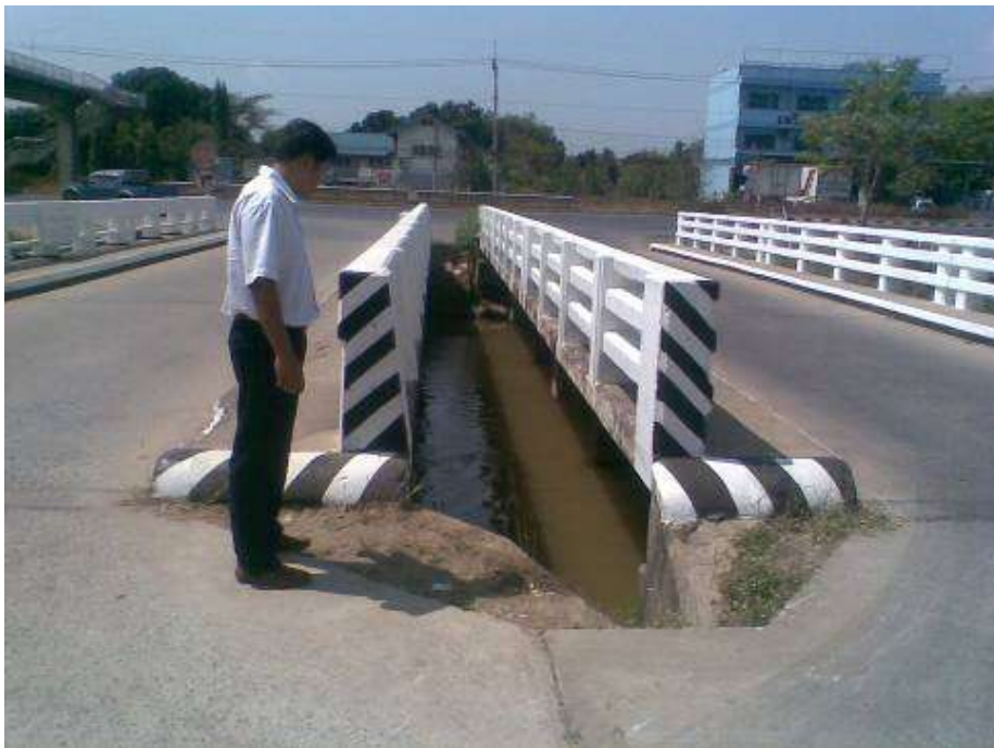
รูปที่ 2.4-5 ปัญหาความไม่ปลอดภัยบริเวณคอสะพาน
