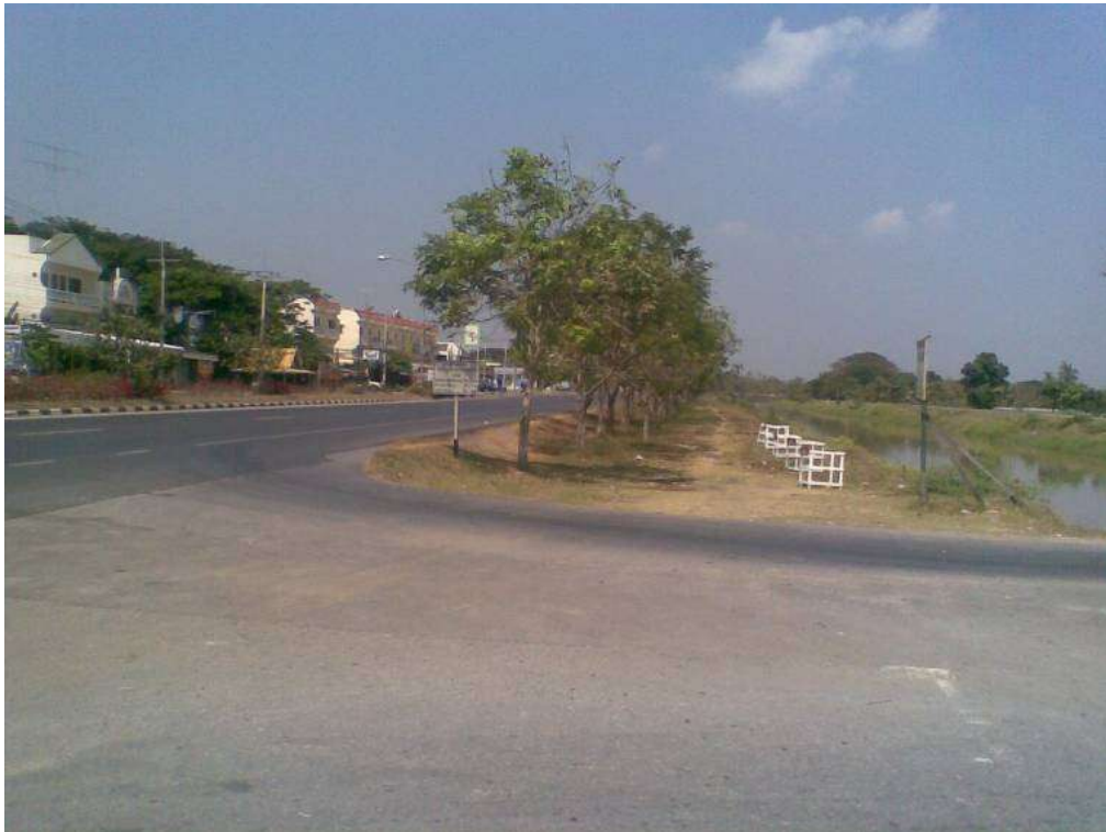
รูปที่ 2.4-7 ปัญหาตีฝ่าวงโค้งที่ไม่เพียงพอบริเวณถนนสายรอง
