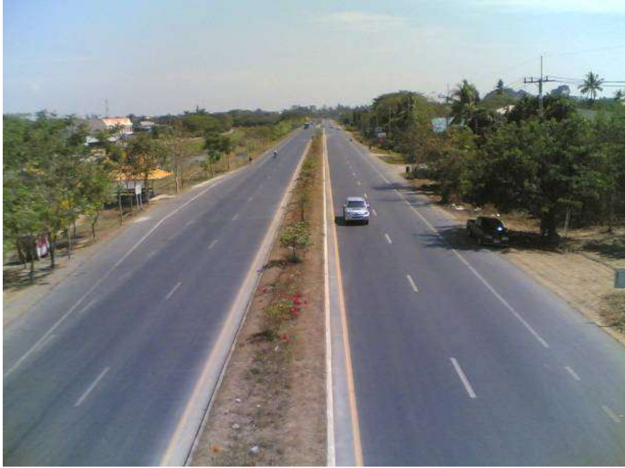
รูปที่ 3.1-1 แสดงลักษณะทางกายภาพของถนนทางหลวงหมายเลข 311
