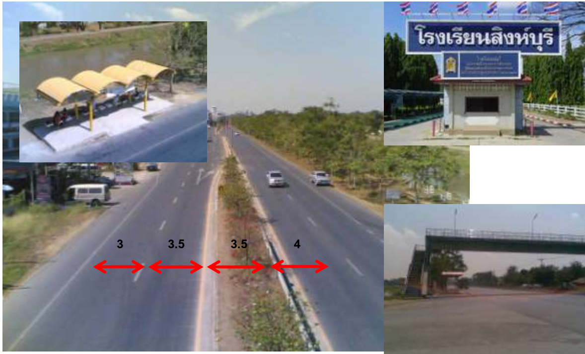
รูปที่ 2.3-2 แสดงลักษณะทางกายภาพถนนทางหลวงหมายเลข 311 บริเวณหน้าโรงเรียนสิงห์บุรี
