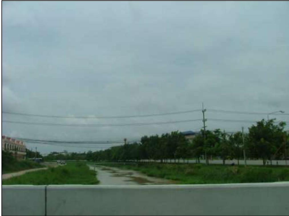
รูปที่ 5.1-6 สภาพปัจจุบันของพื้นที่บริเวณถนนทางหลวงแผ่นดินหมายเลข 311 และถนนเลียบคลองชลประทาน บริเวณโรงเรียนสิงห์บุรี
