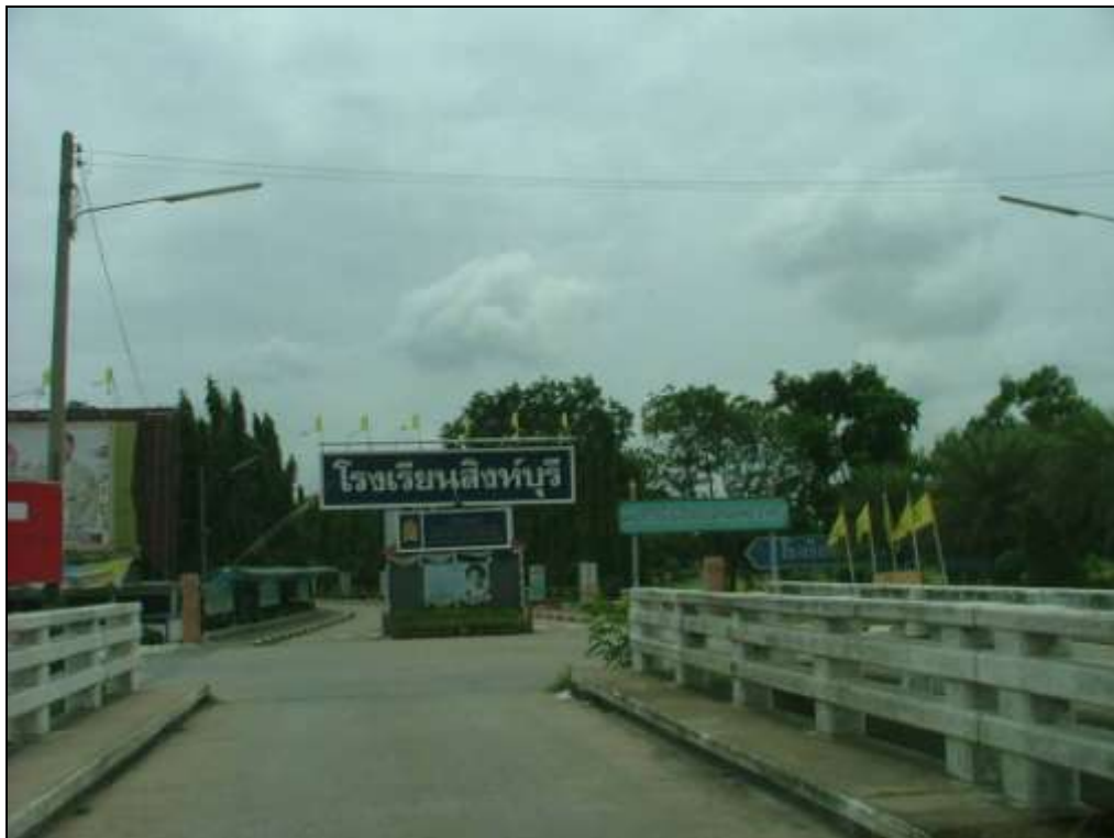
รูปที่ 5.1-7 สภาพปัจจุบันของพื้นที่บริเวณพื้นที่ด้านหน้าโรงเรียนสิงห์บุรี
