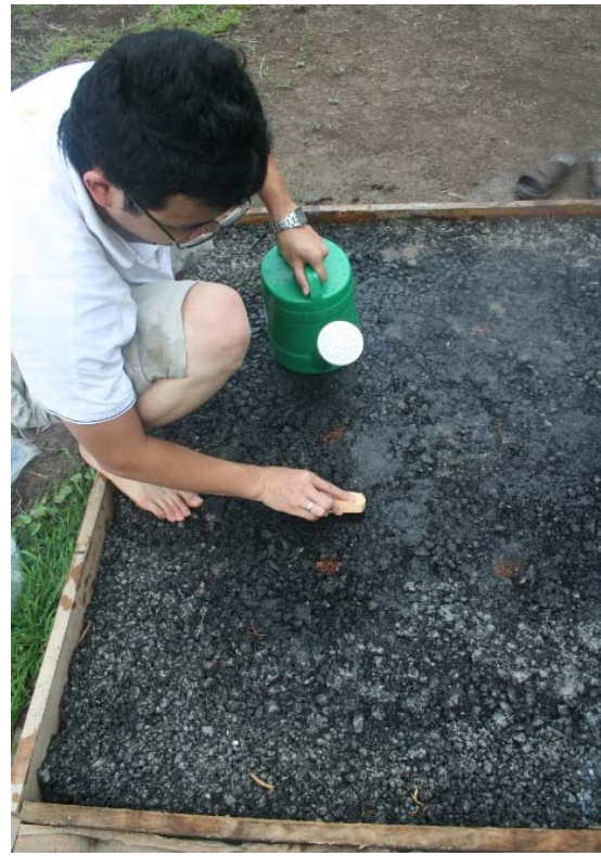
รูปที่ 14 การล้างน้ำและขัดด้วยแปรง
