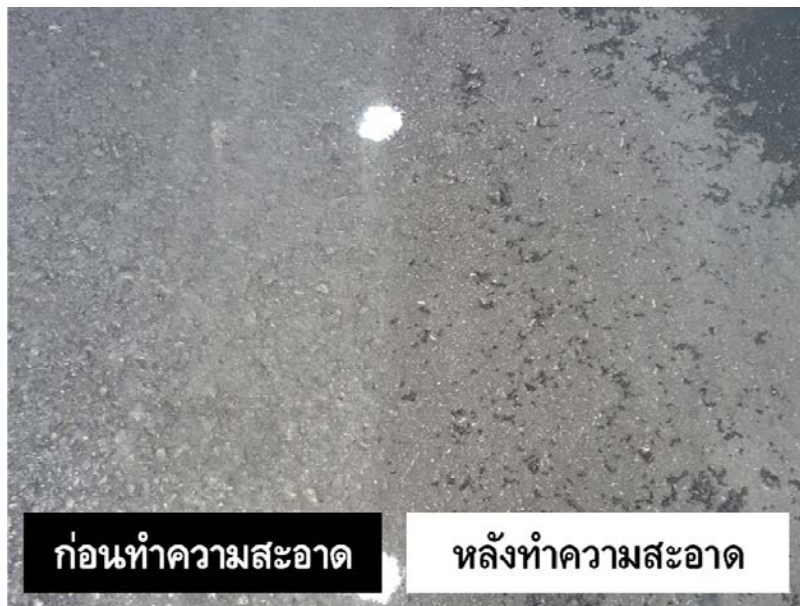
รูปที่ 10 การเปรียบเทียบผิวทางก่อนทำความสะอาดและหลังทำความสะอาด
